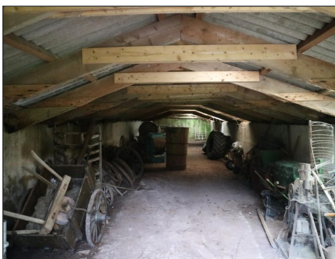
Die Gebäude werden derzeit als Lagerflächen genutzt
