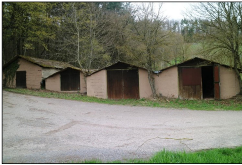
Vier längliche Gebäude der ehemaligen Pilzzucht
