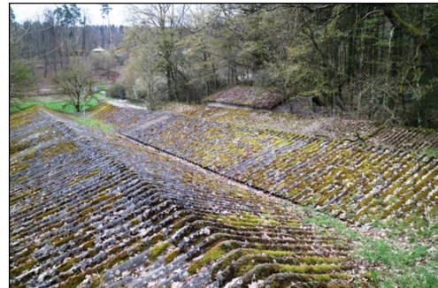
Dachflächen der Gebäude
